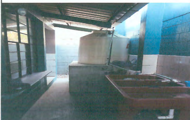
Foto 3: instalacion de base para colocacion de tinaco.
