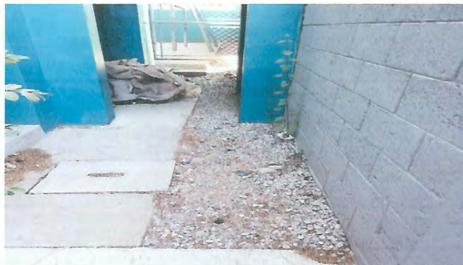
Foto 4: colocacion de concreto .
